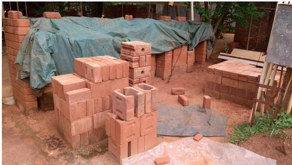
Figura 23. Blocos de terra prensada produzidos no Auroville Earth Institute. Foto do autor.
