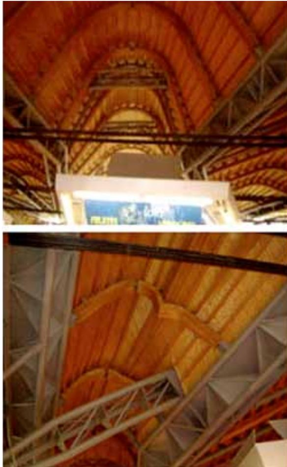
Figura 8. Mercado Santa Caterina em Barcelona vistas internas da cobertura composta de arcos de madeira laminada e estrutura metálica com arcos prismáticos. Fonte: dos Autores.
